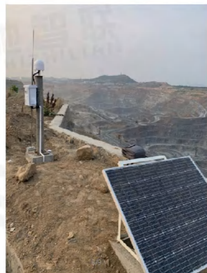
中煤集团边坡监测
